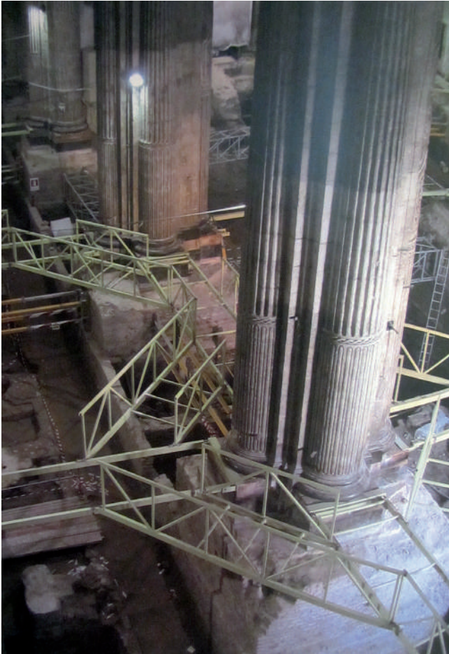
Figura 2. Acodalamiento de pilares y pasarelas para visitas públicas. Fuente: Mendoza Castells, F. (2008). La Iglesia del Salvador de Sevilla: Biografía de una Colegiata . Sevilla: Archidiócesis de Sevilla/ Cajasol, 324
