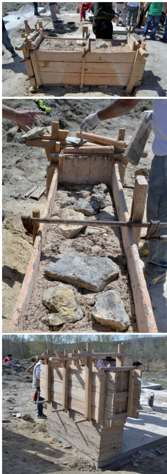
Figura 6. Ejecución de muros de tapia con yeso tradicional (Fotos: izda. C. J. Grau y V. La Spina, 2016).
