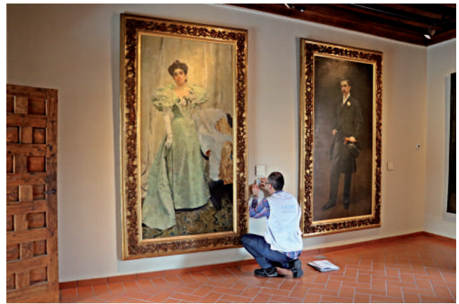
Figura 3. Técnico de la FSMLRPH en proceso de instalación del sistema MHS.
