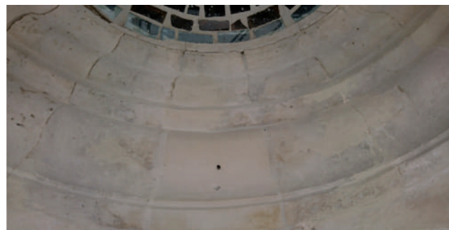
Figura 9. Proceso de reposición de piezas, en este caso de una de las dovelas del óculo. En el centro de la pieza se aprecia un orificio por el que se insertará posteriormente una varilla de acero inoxidable de diámetro 10 cogida con resina Hilti® para anclarla al núcleo del muro, ya consolidado.
