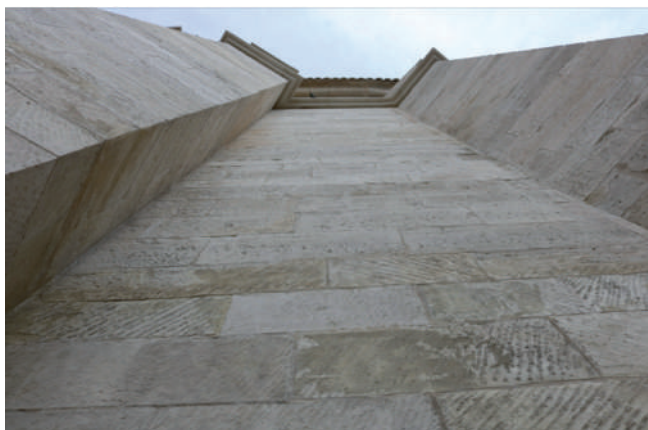
Figura 10. Detalle de la fachada oeste, tramo entre contrafuertes, una vez terminada la obra con la metodología interdisciplinar descrita.
