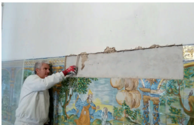
Figura 3. Albañil nivelando un paramento para recolocar unos azulejos. Restaura S.L.
