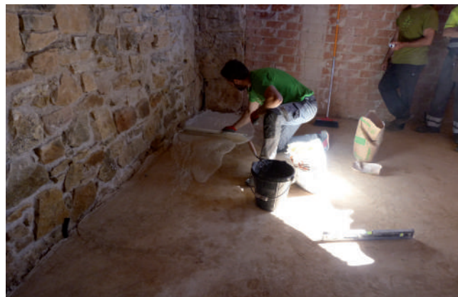
Figura 4. Ejecución de un pavimento continuo de yeso por Andrés Millan Añón durante el XX taller Internacional de arquitectura tradicional en el Rincón de Ademuz. Construcción de pavimentos de yeso organizado por la Universitat Politècnica de València (Foto: S. García Sáez, 2015).
