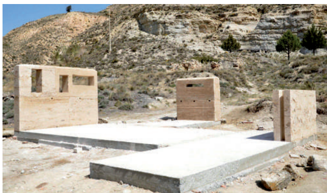
Figura 7. Conjunto de muros de tapia de yeso realizados en la segunda Jornada del yeso tradicional de Teruel en Navarrete del Río, Calamocha, Teruel (Foto: F. Martín Domingo, 2018).
