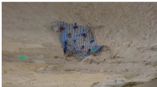
Figura 8. Proceso de aplicación del mortero de restauración, con colocación de varillas de acero inoxidable ancladas con resina Hilti® bicomponente y aplicación de Mallatex®. En la parte inferior de la imagen se aprecia una capa de mortero Naturbase®.
