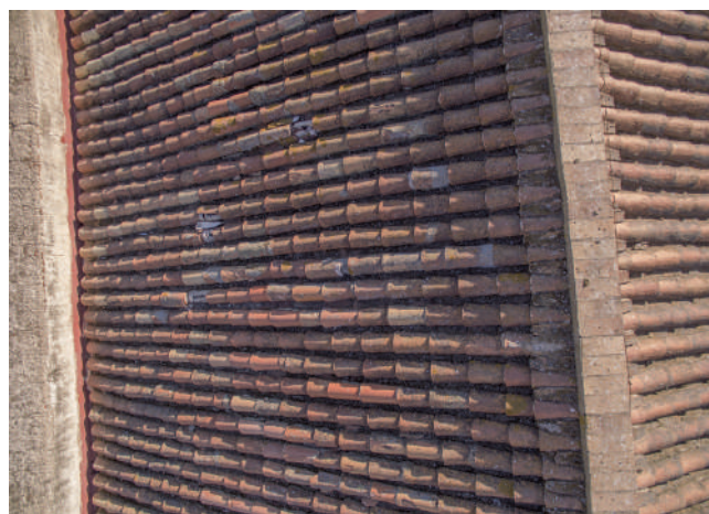
Figura 2. Captura de la inspección de una cubierta de una iglesia con dron para detectar patologías varias (Fotografía de Virtua Nostrum)
