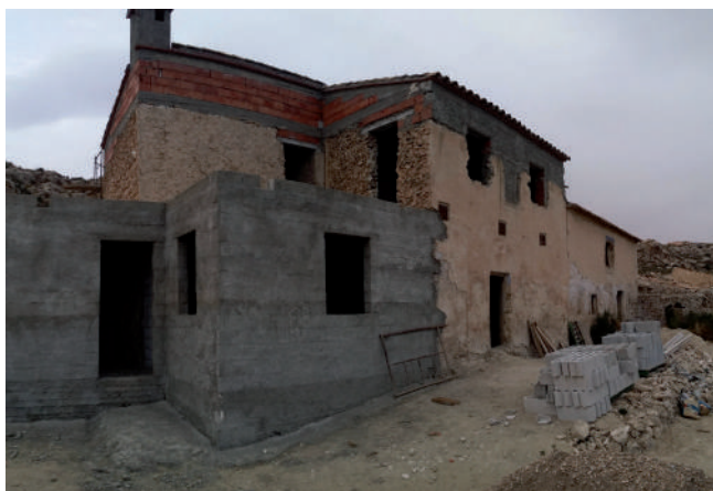
Figura 10. Intervención de 2018 en una construcción histórica en el poblado de Marchalico Viñicas, Sorbas, Almería (Foto: A. Pérez Pérez, 2018)
