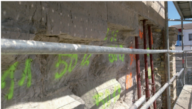
Figura 4. Detalle de marcado de sillares en la fachada sur (fase de 2013) en el que se aprecia la numeración de los sillares según la matriz hilada/sillar y el código de color amarillo-rojo en función de la solución a adoptar, cajeado o sustitución.
