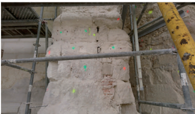
Figura 5. Detalle de marcado de sillares en la fachada oeste (entrada) en la que se aprecia el mismo código de color, incluyendo además el verde para el mortero, y cómo ya se van aplicando las soluciones, de restitución de piedra o aplicación de mortero de restauración (a la izquierda de la foto).
