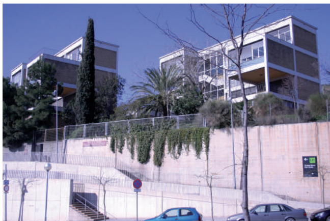
Figura 1. Imagen de la ESCRBCC. Foto Lúdia Balust
