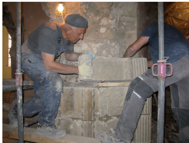
Figura 2. Canteros desmontando una portada para recolocarla en su ubicación original. Talleres de Arte Granda.
