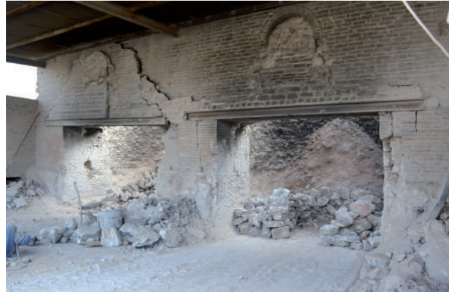
Figura 3. Hornos de yeso tradicional en la fábrica Afimosa en Morón de la Frontera, Sevilla (Foto: C. J. Grau y V. La Spina, 2016).
