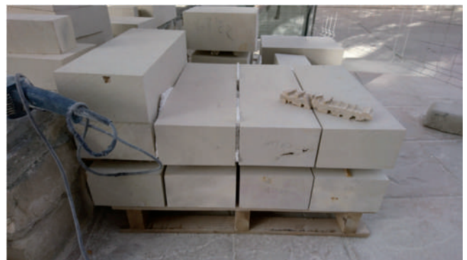
Figura 7. Inspección de las piezas cortadas a su llegada a obra
