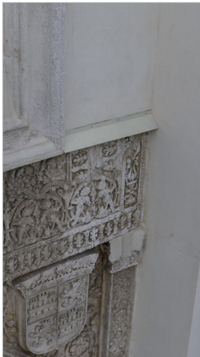
Figura 6.- Lámina de protección de las yeserías. Portada del Perdón.
