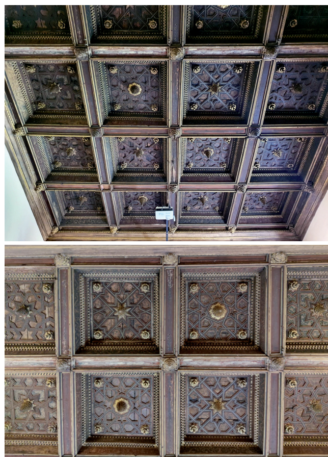
Figura 9.- Techumbre del estrado del Salón de Actos de la Real Academia de Bellas Artes. Fotografías propias.
