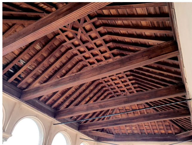
Figura 10.- Techumbre del torreón-mirador. Fotografía propia.
