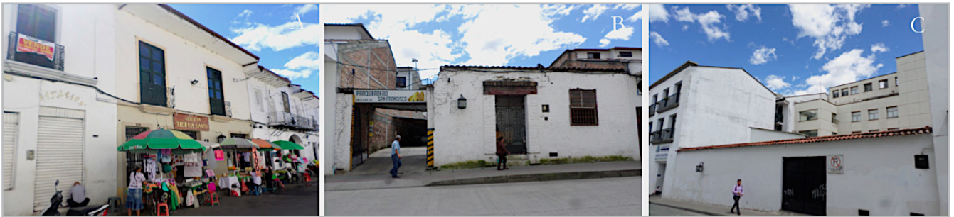
Figura 3.- Alteración del paisaje urbano en el centro histórico A) Ocupación del espacio público, por uso comercial informal, frente a la iglesia de La Encarnación B) Antigua casa convertida en parqueadero sobre la calle 4 frente a la iglesia de San Francisco C) Alteración del perfil urbano por construcción de nuevas edificaciones, edificio sobre la carrera novena, con calle 4.
