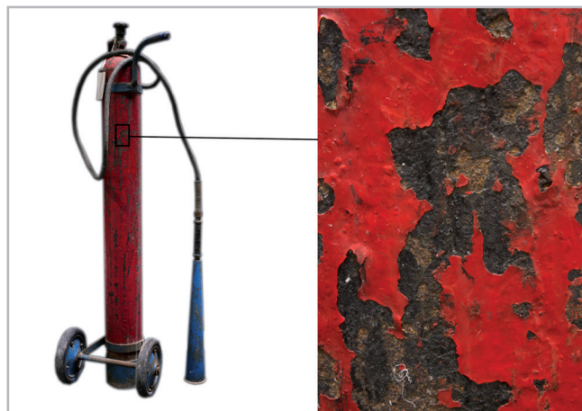
Figura 8. -Detalle del estado del recubrimiento en el extintor Kustos con nº de inventario 1991/019/0040.
