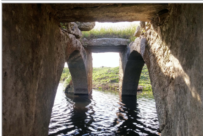
Figura 7.- Cárcavo del centro de la nave, visto por debajo y por arriba. No se trata de un “hundimiento”, sino de un espacio rectangular configurado para un fin. Fuente: Elaboración propia
