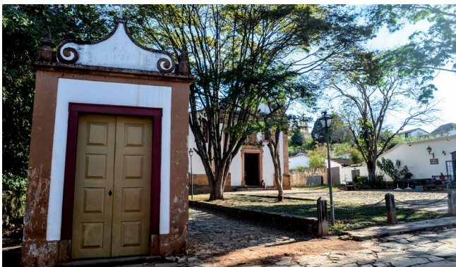
Figura 4. - Passo de Rua no Largo do Rosário próxima a Cadeia, vista externa para fachada com a Capela do Rosário ao fundo, Tiradentes. Autoria: David Nascimento, 2017.
