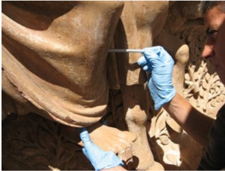
Foto 7- Sustitución de varilla de anclaje en una figura del tímpano de la portada de la Campanilla. Año 2009
