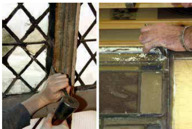
Figura 3. Extracción de un panel eliminando el sellamiento perimetral de mortero (imagen izquierda) o de masilla (imagen derecha) mediante martillo y cincel o espátula. Fotos: Fernando Cortés Pizano ©. Imagen izquierda reproducida con permiso del Dean and Chapter de la Catedral de Lincoln
