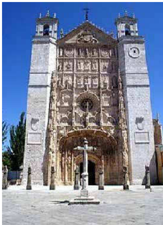
Figura 1.- Imagen de la fachada de San Pablo tras su restauración
