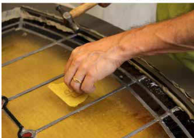
Figura 16. Proceso de montaje de los paneles de una vidriera en ventanal de piedra mediante mortero (imagen superior) y en ventanal de madera mediante masilla y junquillos (imagen inferior). Fotos: Fernando Cortés Pizano ©. Imagen superior reproducida con permiso del Dean and Chapter de la Catedral de Lincoln
