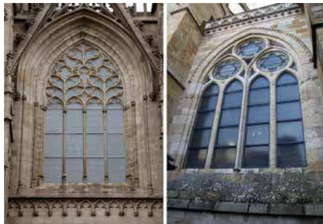
Figura 17. Sistemas exteriores de protección de vidrieras. Imagen izquierda: acristalamiento isotérmico en la Catedral de Barcelona; imagen derecha: acristalamiento isotérmico y mallas de protección en la catedral de León. Fotos: Fernando Cortés Pizano ©
