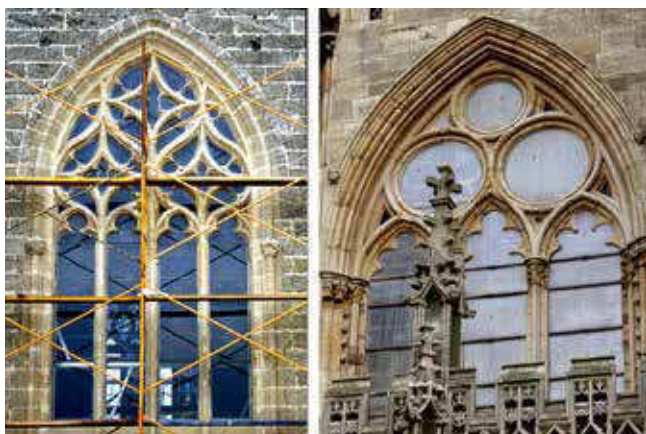
Figura 5. Distintos sistemas de cerramiento provisional de un ventanal mediante láminas de vidrio (imagen izquierda) y mediante láminas de policarbonato (imagen derecha). Fotos: Fernando Cortés Pizano ©. Imagen derecha reproducida con permiso del Dean and Chapter de la Catedral de Lincoln
