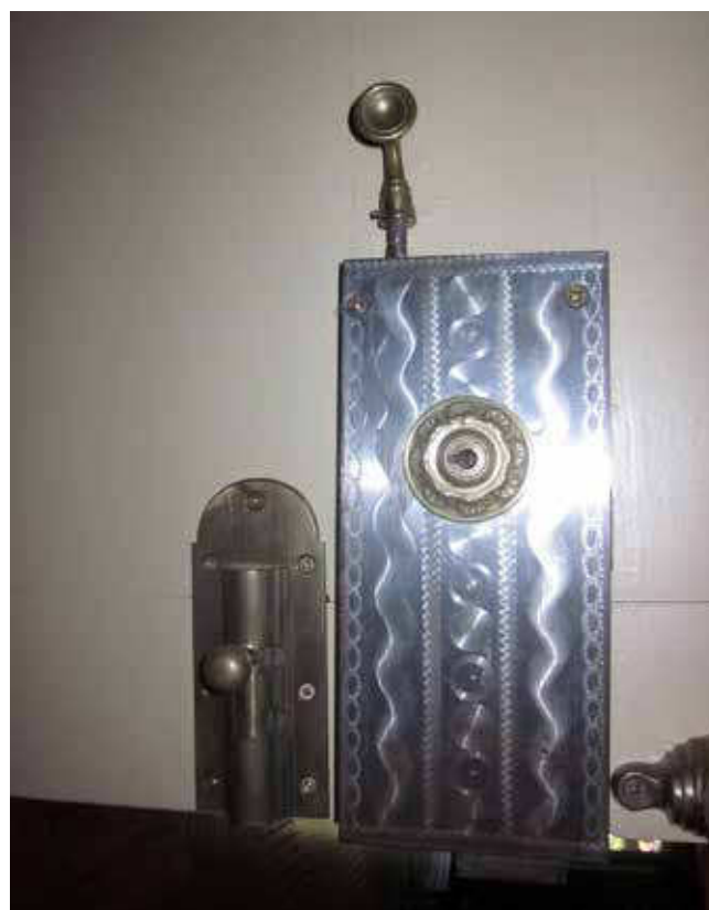
Figura 6. Detalle de uno de los cerrojos, después del tratamiento efectuado. ©Sofía de Alfonso Alonso-Muñoyerro
