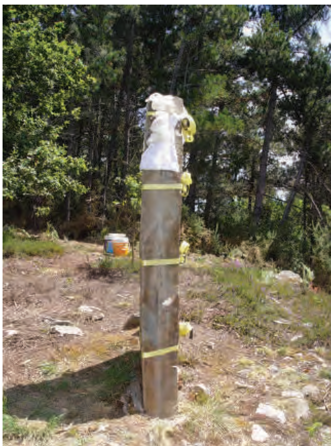
Figuras 11, 12, 13. Colocación de sistemas de sujeción, mientras se produce el correcto fraguado de la cal.
