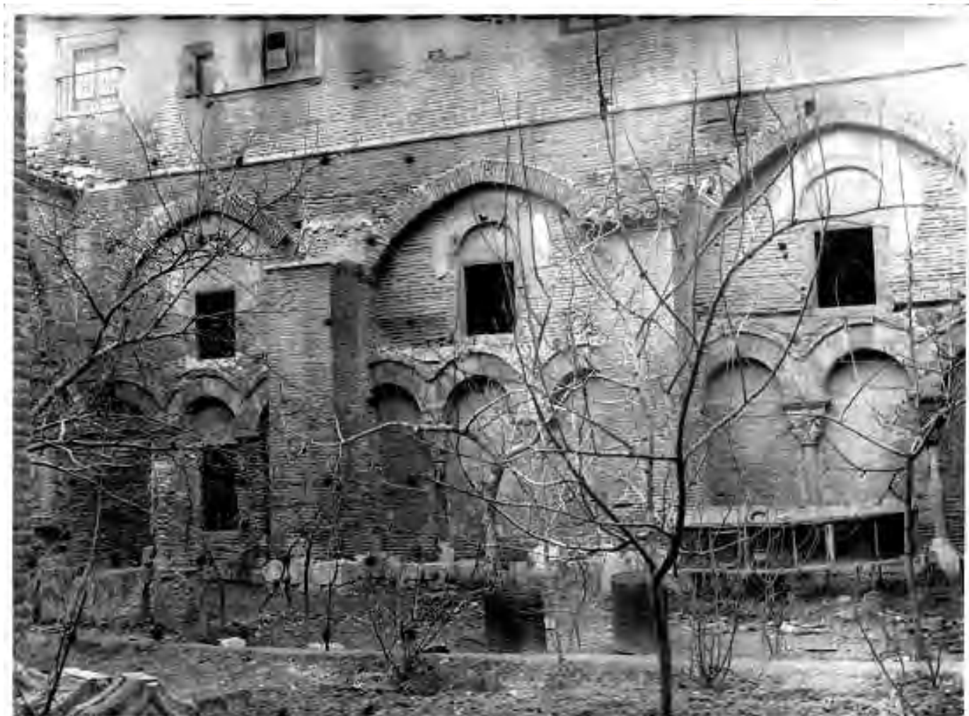
Figura 4. Vista general del claustro desde el huerto, en 1916
