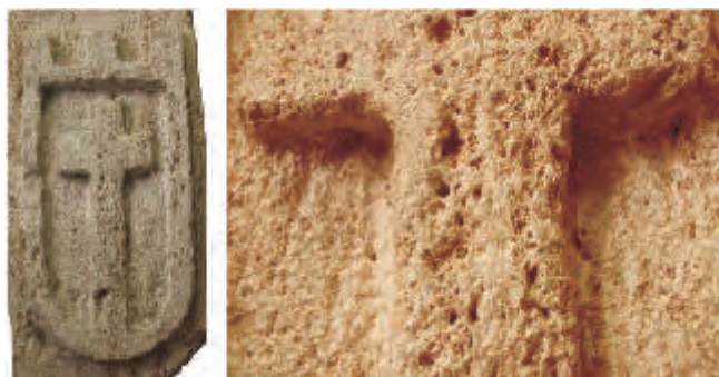
Figura 4. Vista general de la obra objeto de estudio. Obsérvese en la figura de detalle la macroporosidad de la piedra Tosca de Rocafort.
