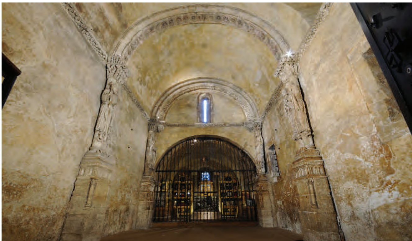
Figura 1. Aspecto general del interior de la Cámara Santa. Una heterogénea pátina amarillenta cubre la mayor parte de los materiales y contribuye en gran manera a la particular percepción de este reducido espacio, hasta este momento.
