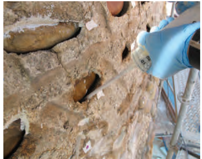
Figura 6. Inyección del mortero fluidificado con una jeringuilla grande acoplada a una cánula de plástico
