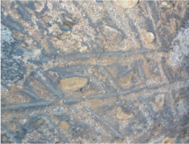
Figura 5. Costra negra se concentra en mayor medida sobre las zonas cóncavas, tanto de las incisiones que marcan la decoración del revoco como del mortero que rodea los cantos rodados
