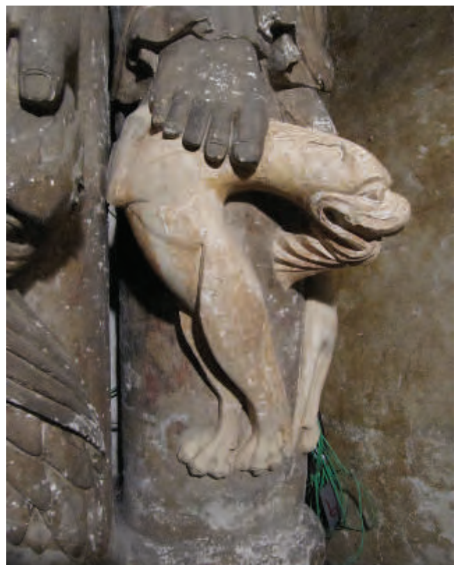
Figura 3. Resultado de la limpieza Láser en la columna de San Bartolomé y Santo Tomás.
