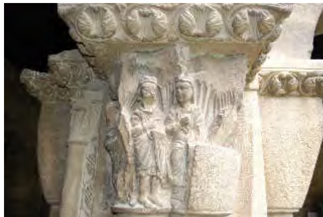
Figura 11. Lesiones antiguas estables en un capitel colocado con sólido capaz de arenisca en 1940.
