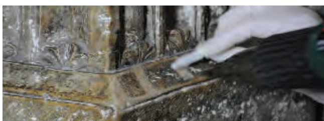
Figura 8. Catas de limpieza con aire caliente y white spirit realizadas en el pedestal de la columna de San Pedro y San Pablo.
