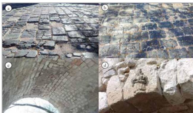
**Figura 6.-** a) y b) Daños y pérdidas de piezas en el embaldosado de escoria del puente “San Ignacio”. c) y d) Pérdida de juntas y daño en dovelas en el intradós de las bóvedas. Elaboración propia.
