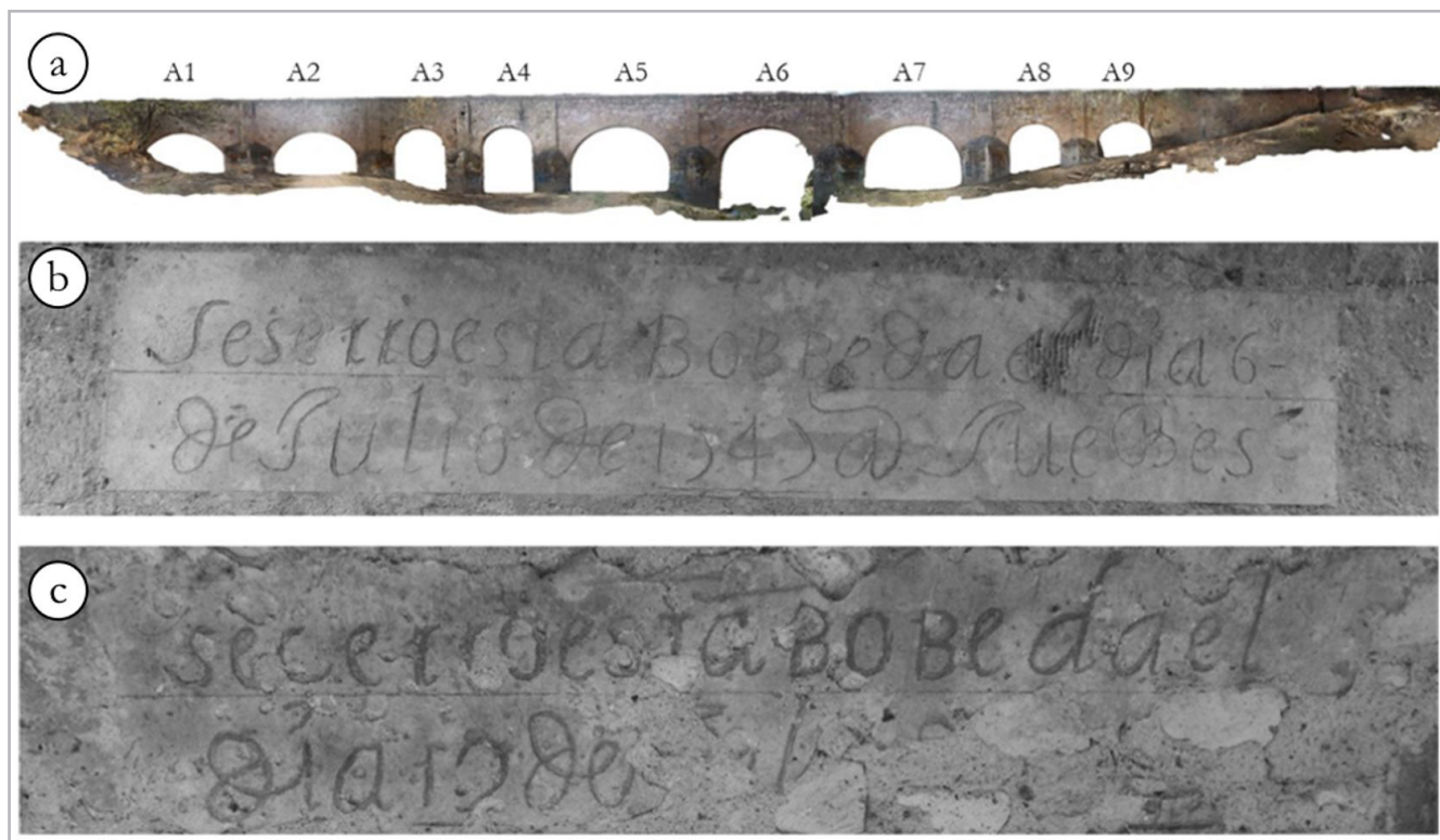
Figura 1.- a) Perfil del puente “San Ignacio” b) y c) grabados en estuco de cal (A8, A9), indicando la fecha de cierre de las bóvedas de los arcos del puente. Elaboración propia.
