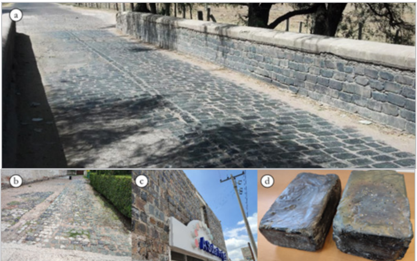
Figura 4.- a) Embaldosado y sustitución del parapeto con baldosas de escoria de fundición. b) Embaldosado en patio de maniobras de la ASARCO. c) Edificio administrativo de la ASARCO, construido con el material. d) Baldosas de escoria rescatadas de la ASARCO. Elaboración propia.
