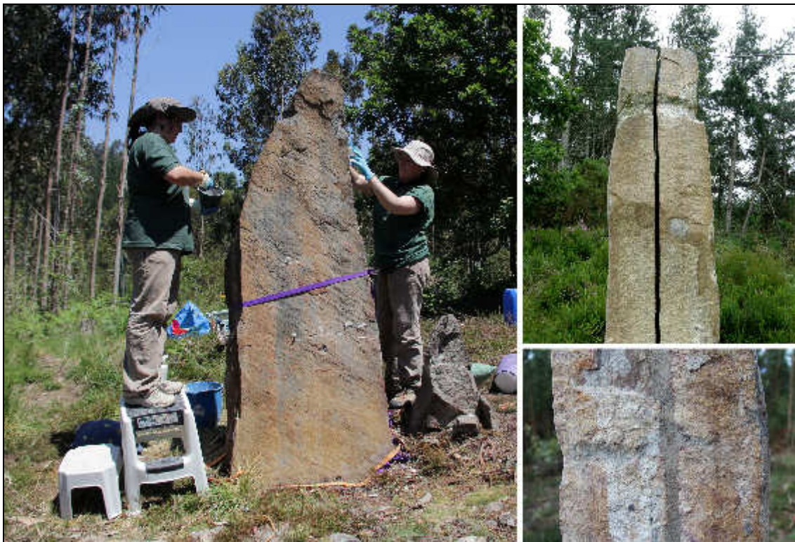
Foto 1: Proceso de restauración del menhir de Sorbituaga-Arriatara (Busturia). Detalle de la grieta antes y después de su consolidación con morteros de cal hidráulica.
