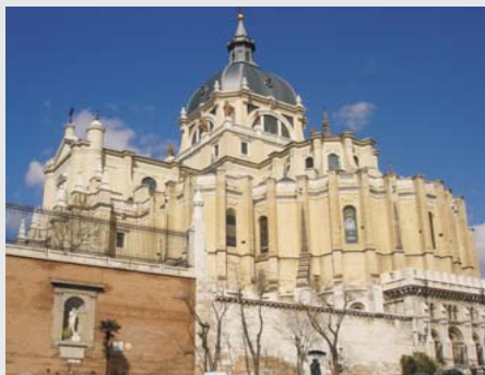
Cripta y Catedral de Santa María la Real de La Almdena (Madrid), construida con materiales pétreos naturales.
