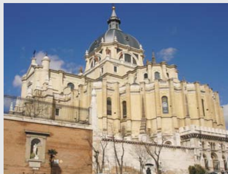
Cripta y Catedral de Santa María la Real de La Almdudena (Madrid), construida con materiales pétreos naturales.
