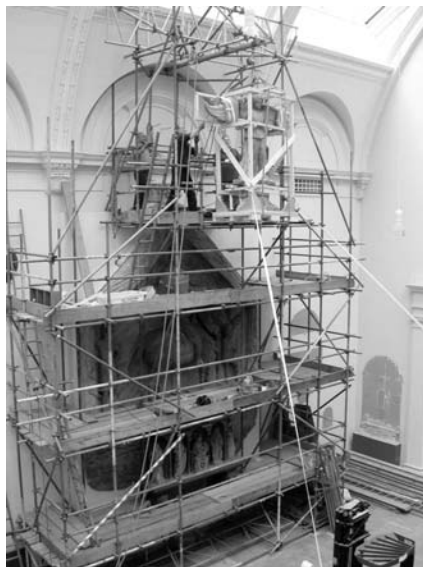
Fig. 5: Operaciones de transporte realizadas por el equipo de servicios técnicos
