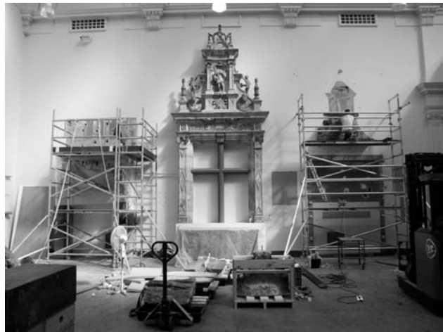
Fig. 4: Desmontaje de las obras en el muro norte de la sala 50
