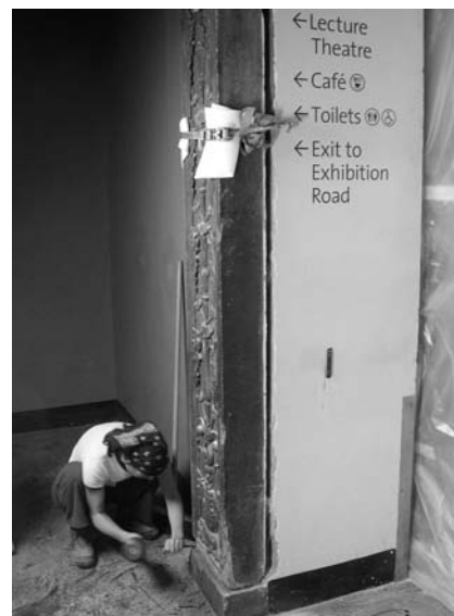
Fig. 6: Labores de desmontaje de un pórtico italiano por una conservadora
