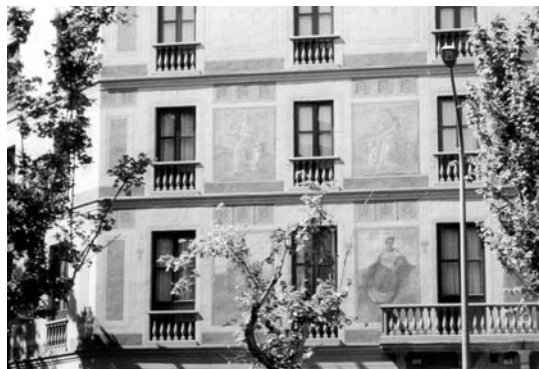
Fig. 5: Casa Cerdà de Barcelona (s. XIX): ejemplo de conjunto decorativo mural exterior, ejecutado en una técnica mixta (fresco acabado a seco)
