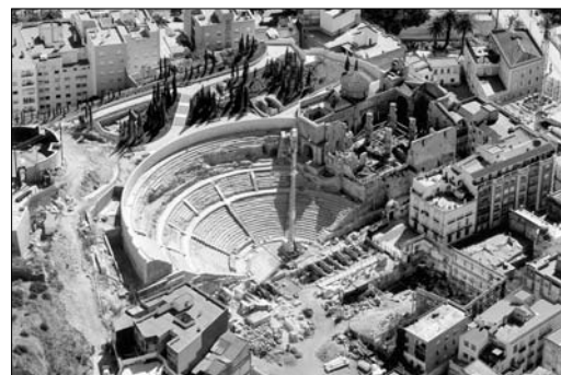
Fig. 10: Vista aérea de la cavea con los trabajos de restauración concluidos
