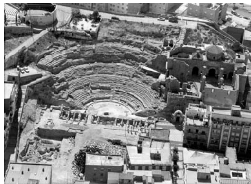
Fig. 2: Vista aérea del teatro antes de iniciar la restauración
