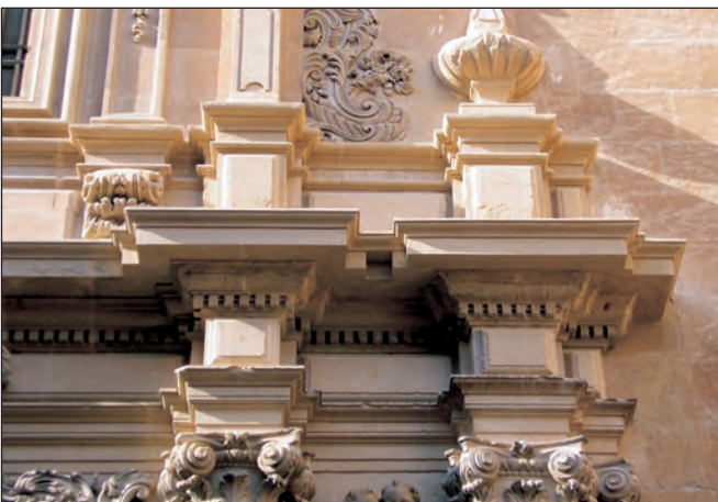
Fig. 5. Detalle de la cornisa tras la reposición mediante el uso de morteros pétreos.
