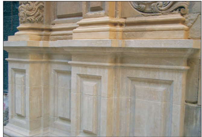
Fig. 4. Detalle de la base de sillería tras la reposición con piedra natural.
